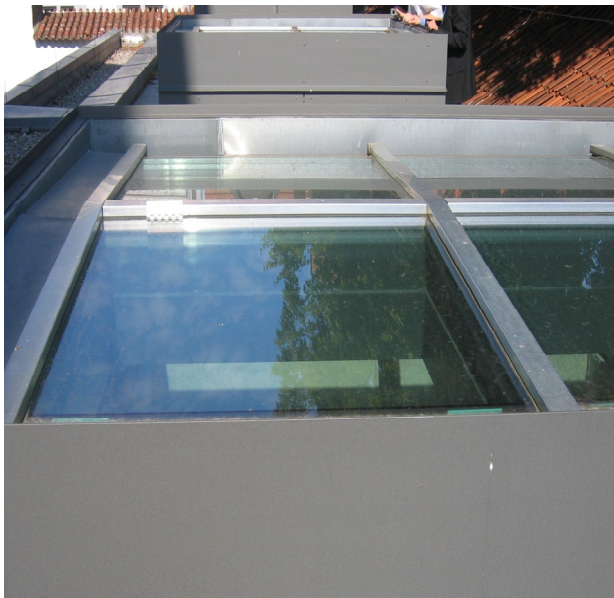
Bild 1: Blick über die Oberlichter bestehend aus wärme-gedämmten Stahlfenstern mit Wärmeschutzverglasung (Stufenverglasung)
